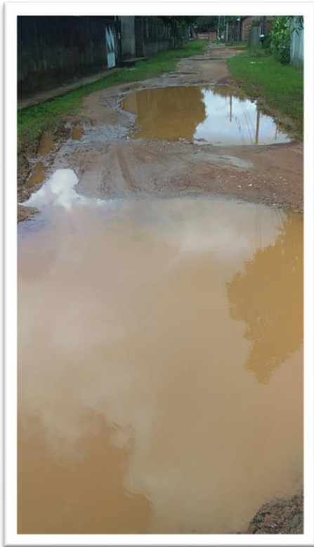
Figura 1-Pavimentação de Via Pública.
