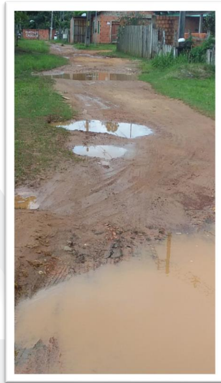
Figura 2-Pavimentação de Via Pública.
