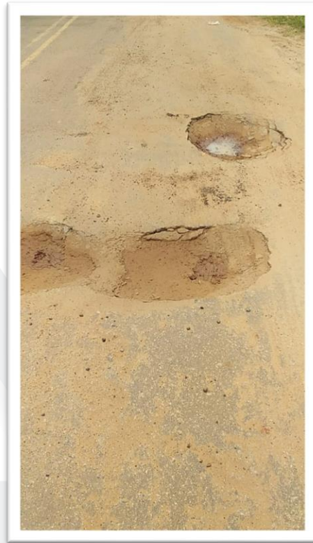
Figura 2-Pavimentação de Via Pública.
