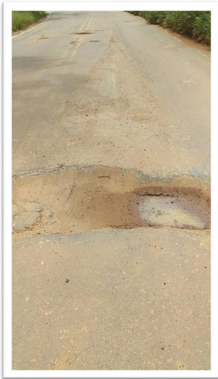
Figura 1-Pavimentação de Via Pública.
