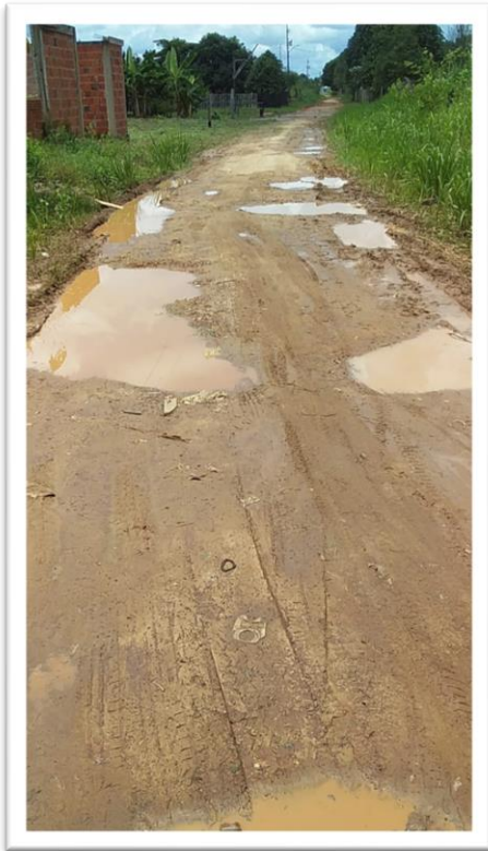
Figura 1-Pavimentação de Via Pública.
