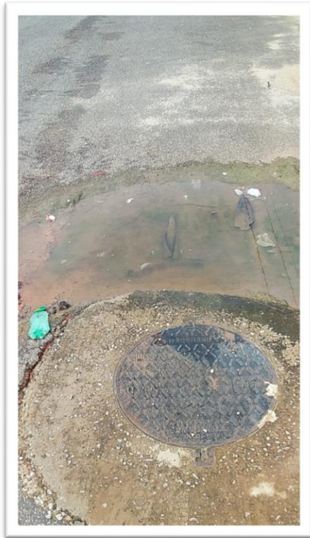
Figura 1-Desobstrução de Bueiro em Via Pública.
