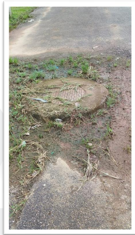
Figura 2-Desobstrução de Bueiro em Via Pública.
