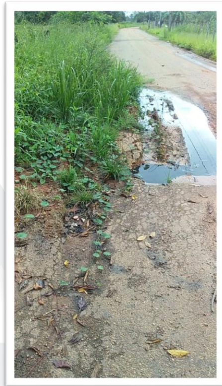
Figura 2- Desobstrução de Bueiro em Via Pública.
