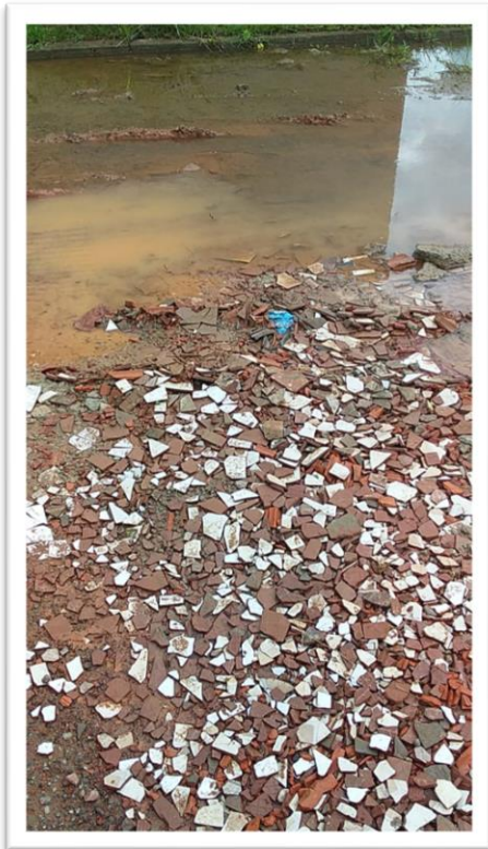
Figura 1-Pavimentação de Via Pública.
