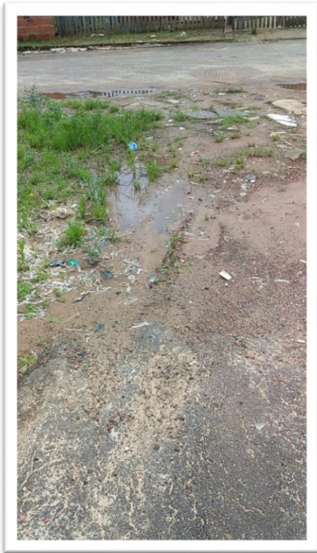
Figura 1-Pavimentação de Via Pública.
