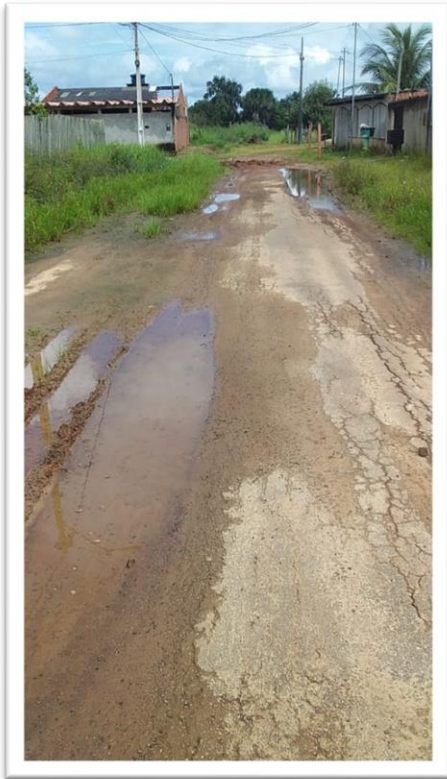
Figura 1-Pavimentação de Via Pública.
