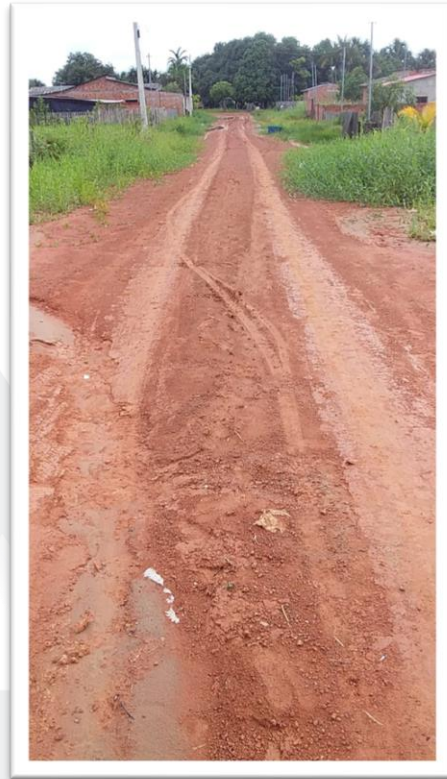
Figura 2-Pavimentação de Via Pública.
