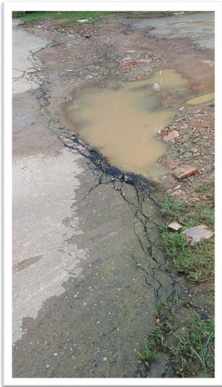
Figura 1-Pavimentação de Via Pública.
