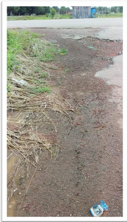
Figura 1-Pavimentação de Via Pública.
