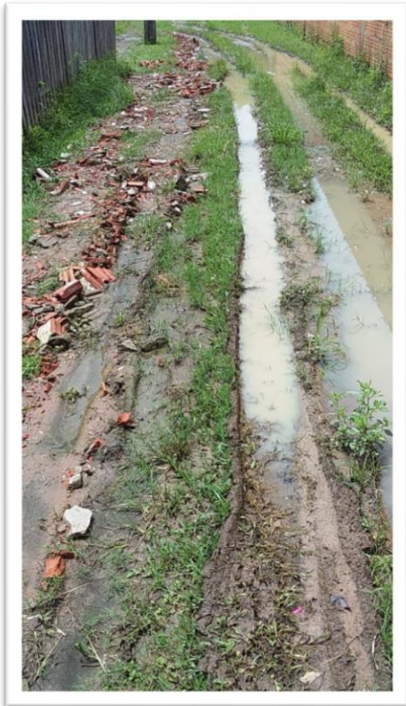
Figura 1-Pavimentação de Via Pública.
