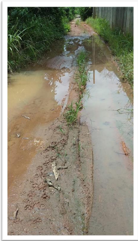
Figura 1-Pavimentação de Via Pública.
