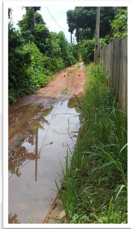
Figura 2-Pavimentação de Via Pública.
