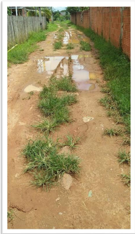
Figura 1-Pavimentação de Via Pública.
