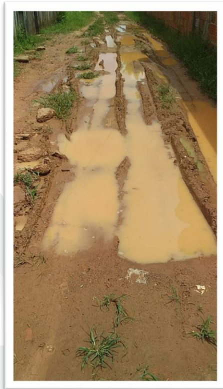
Figura 2-Pavimentação de Via Pública.
