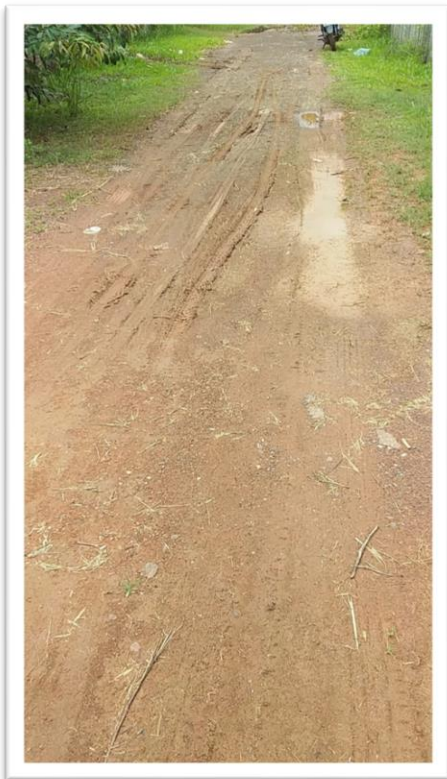
Figura 1-Pavimentação de Via Pública.
