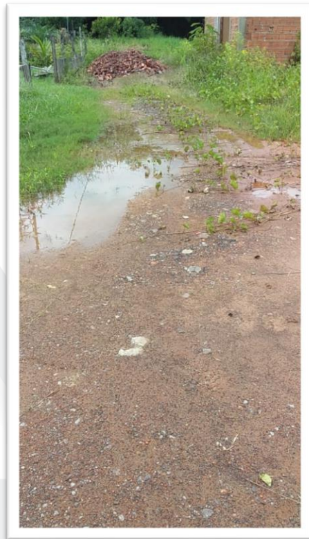
Figura 2-Pavimentação de Via Pública.
