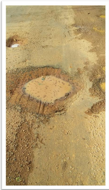
Figura 1-Pavimentação de Via Pública.
