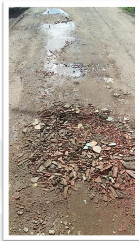
Figura 2-Pavimentação de Via Pública.
