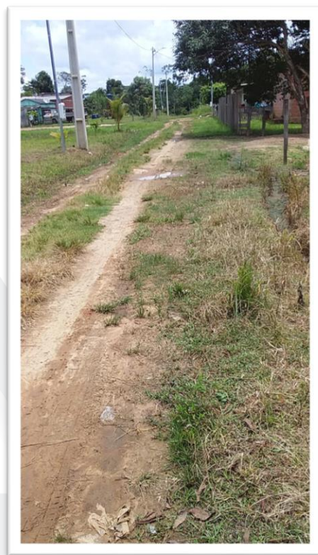
Figura 2-Pavimentação de Via Pública.
