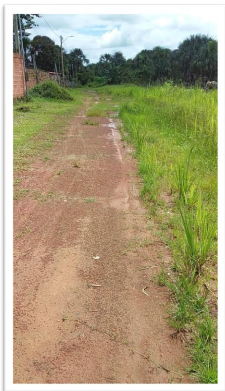
Figura 1-Pavimentação de Via Pública.
