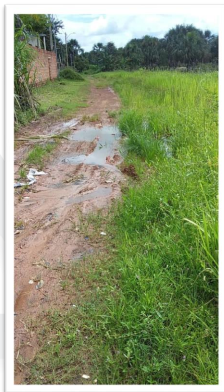
Figura 2- Pavimentação de Via Pública.
