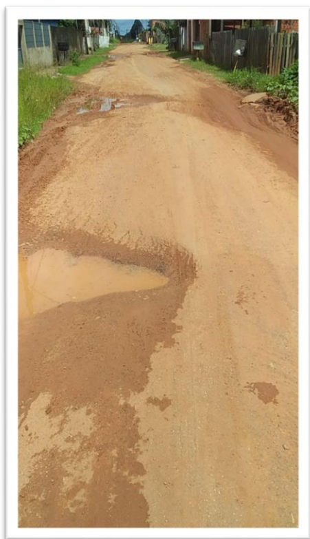
Figura 1-Pavimentação de Via Pública.
