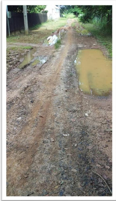
Figura 1-Pavimentação de Via Pública.
