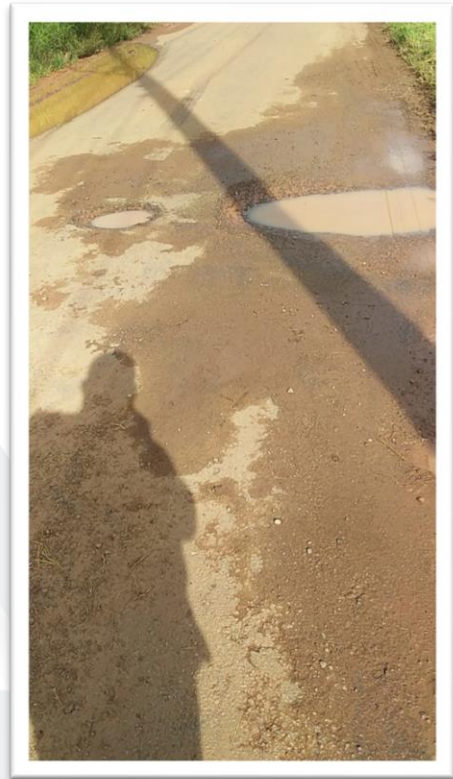
Figura 2-Pavimentação de Via Pública.
