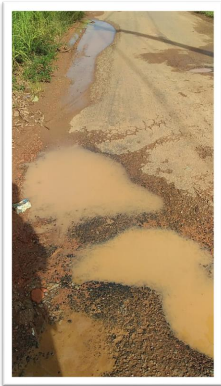
Figura 1-Pavimentação de Via Pública.
