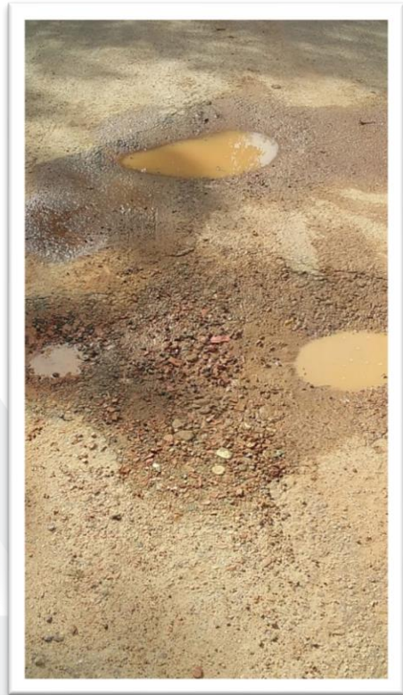
Figura 2-Pavimentação em Via Pública.
