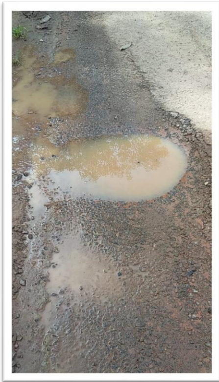
Figura 1-Pavimentação em Via Pública.
