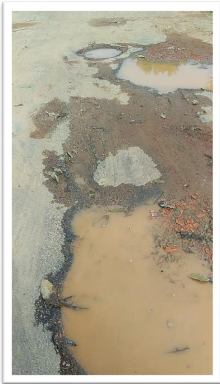
Figura 1-Pavimentação em Via Pública.
