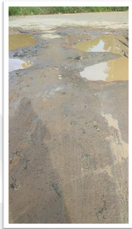
Figura 2-Pavimentação de Via Pública.
