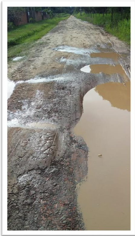
Figura 1-Pavimentação de Via Pública.
