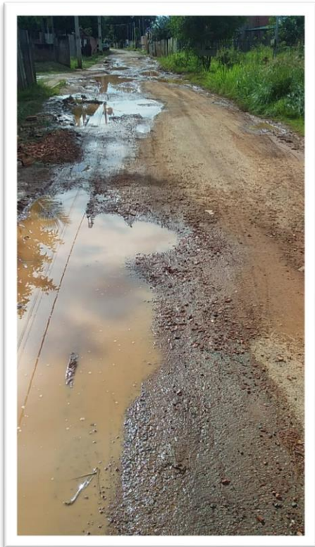
Figura 1-Pavimentação de Via Pública.
