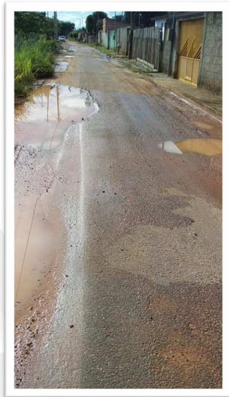
Figura 2-Pavimentação de Via Pública.
