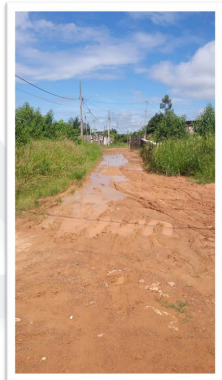
Figura 2- Pavimentação de via pública.
