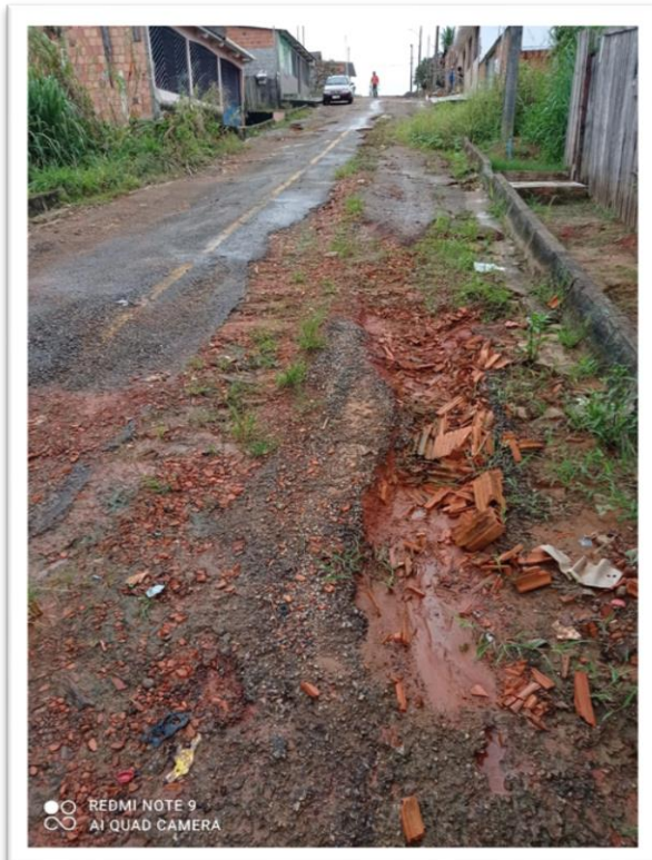
Figura 1- Pavimentação de via pública.
