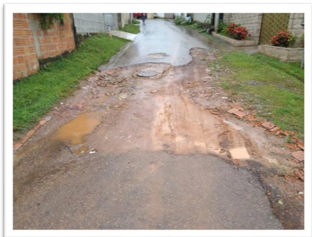
Figura 1- Pavimentação de via pública.
