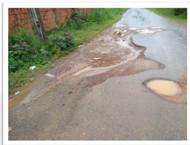
Figura 2- Pavimentação de via pública.
