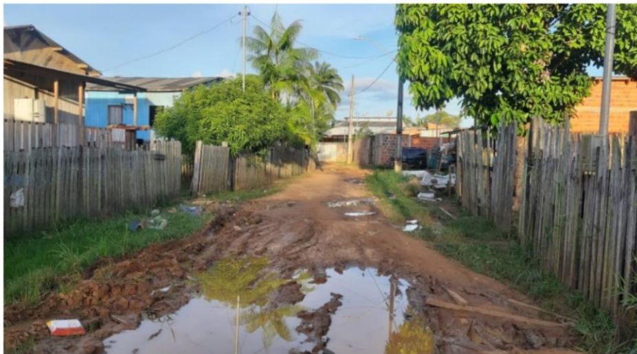
Figura 1- Pavimentação de via pública.
