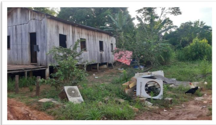
Figura 1- Limpeza de via pública.
