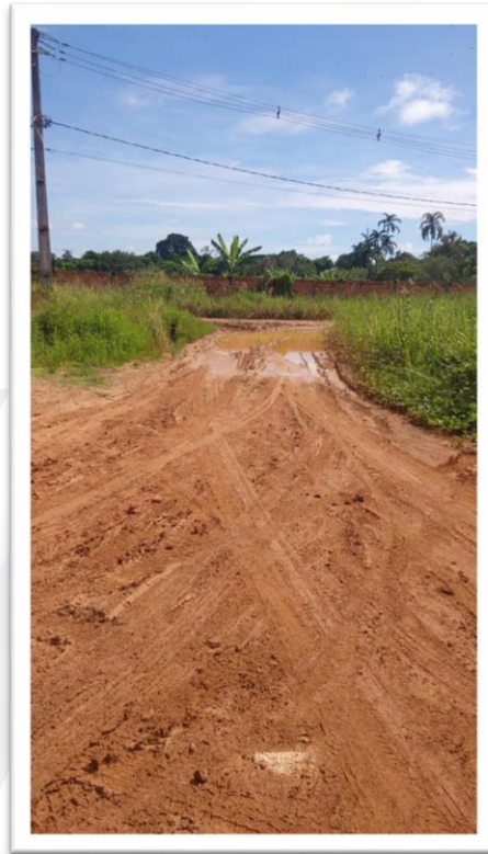
Figura 2- Pavimentação de Via Pública.
