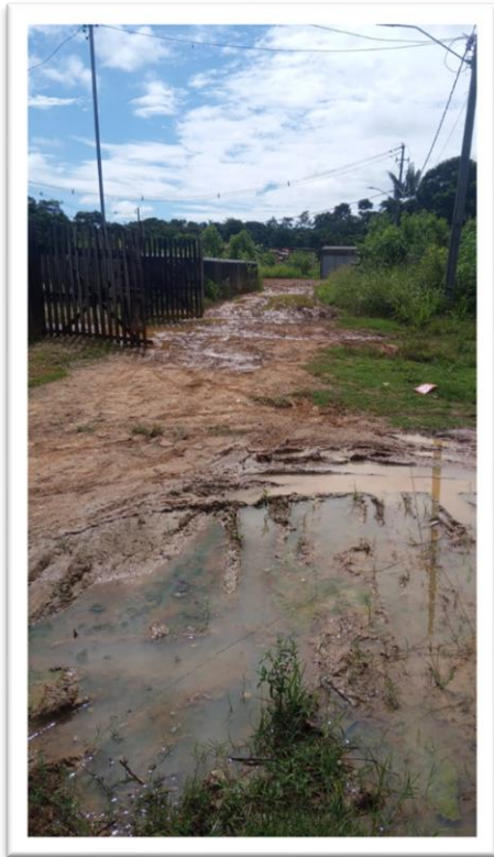
Figura 1- Pavimentação de Via Pública.
