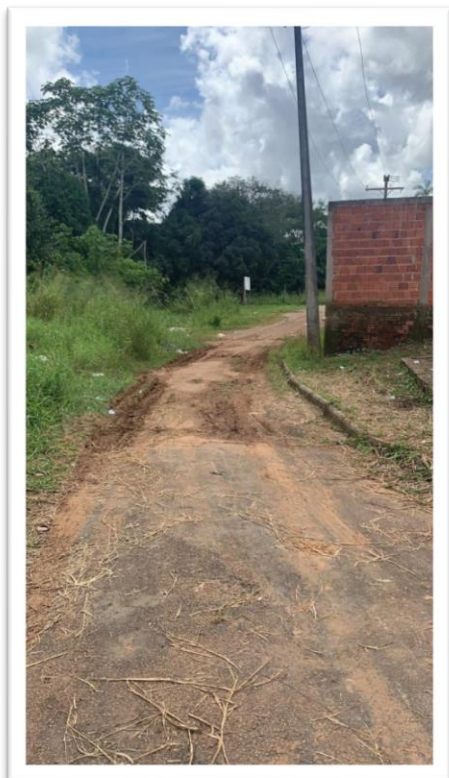
Figura 1- Pavimentação de via pública.
