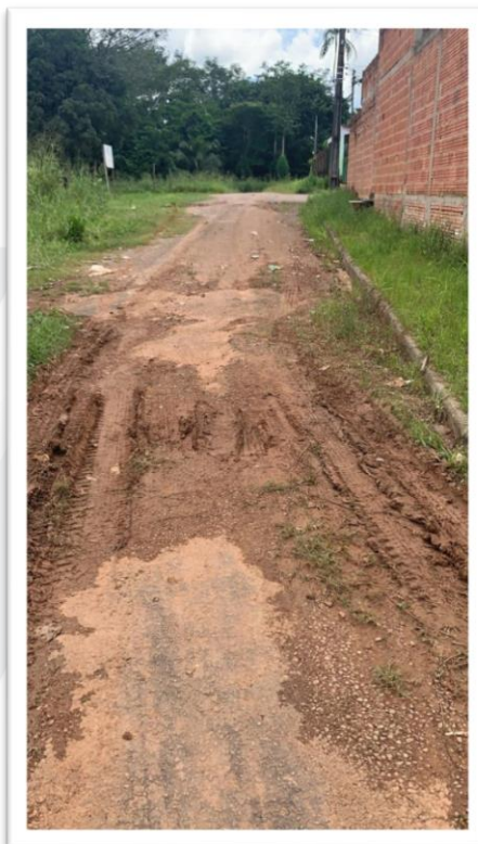
Figura 2- Pavimentação de via pública.
