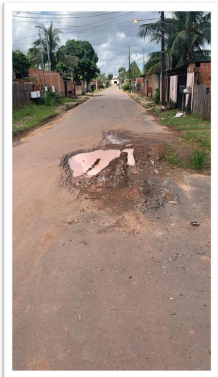
Figura 1- Pavimentação de via pública.
