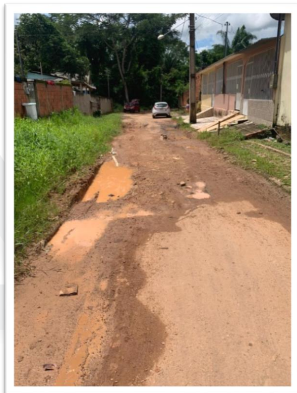
Figura 2- Pavimentação de via pública.
