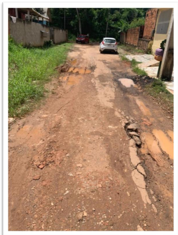
Figura 1- Pavimentação de via pública.
