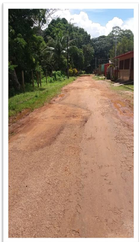
Figura 1- Pavimentação de via pública.
