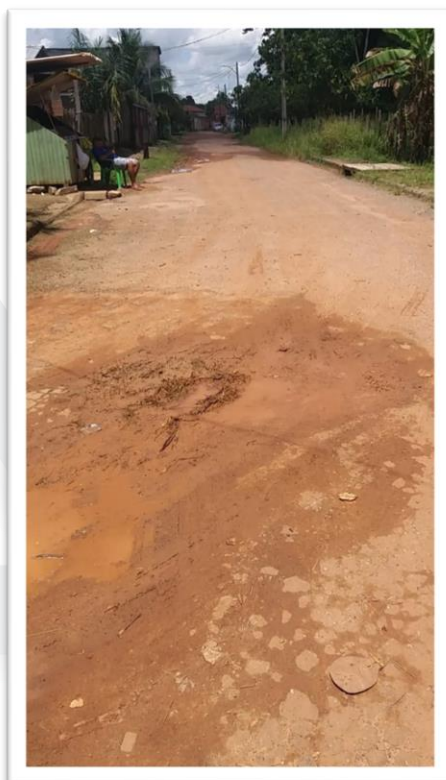
Figura 2- Pavimentação de via pública.
