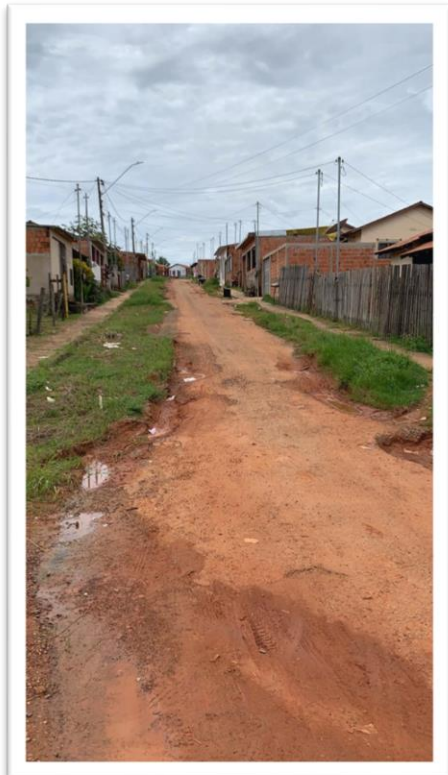
Figura 1- Pavimentação de via pública.
