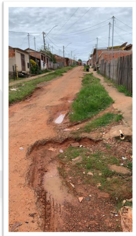
Figura 2- Pavimentação de via pública.
