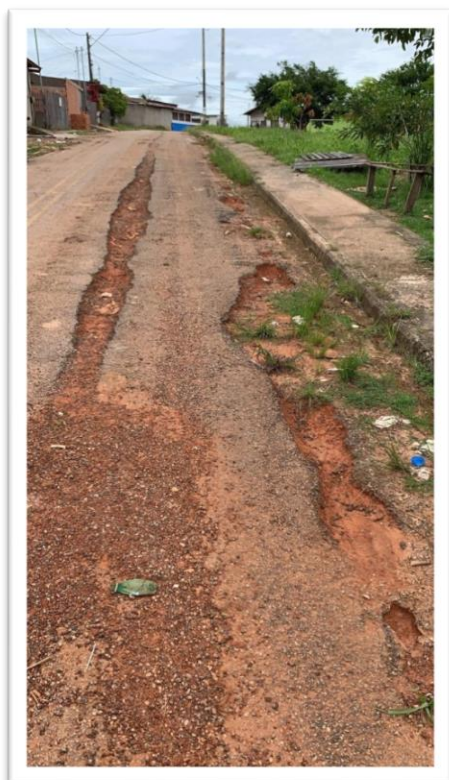
Figura 1- Pavimentação de via pública.
