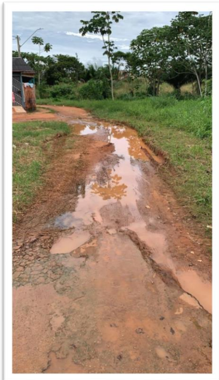
Figura 1- Pavimentação de via pública.
