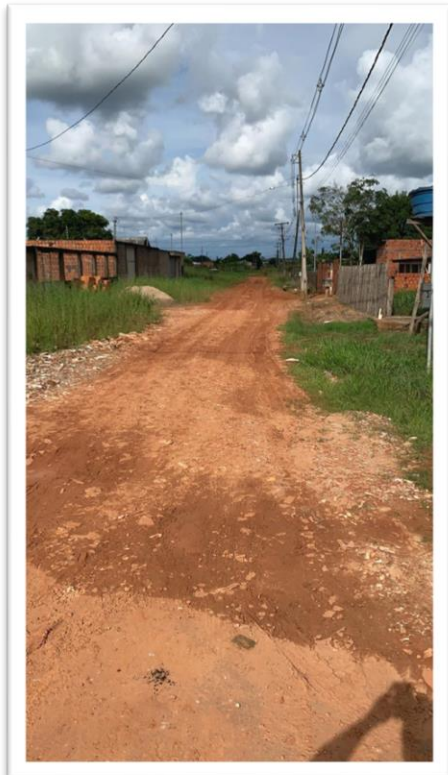
Figura 1- Pavimentação de via pública.
