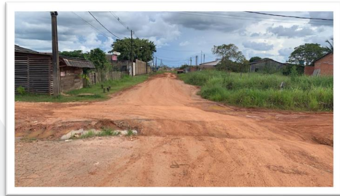
Figura 2- Pavimentação de via pública.
