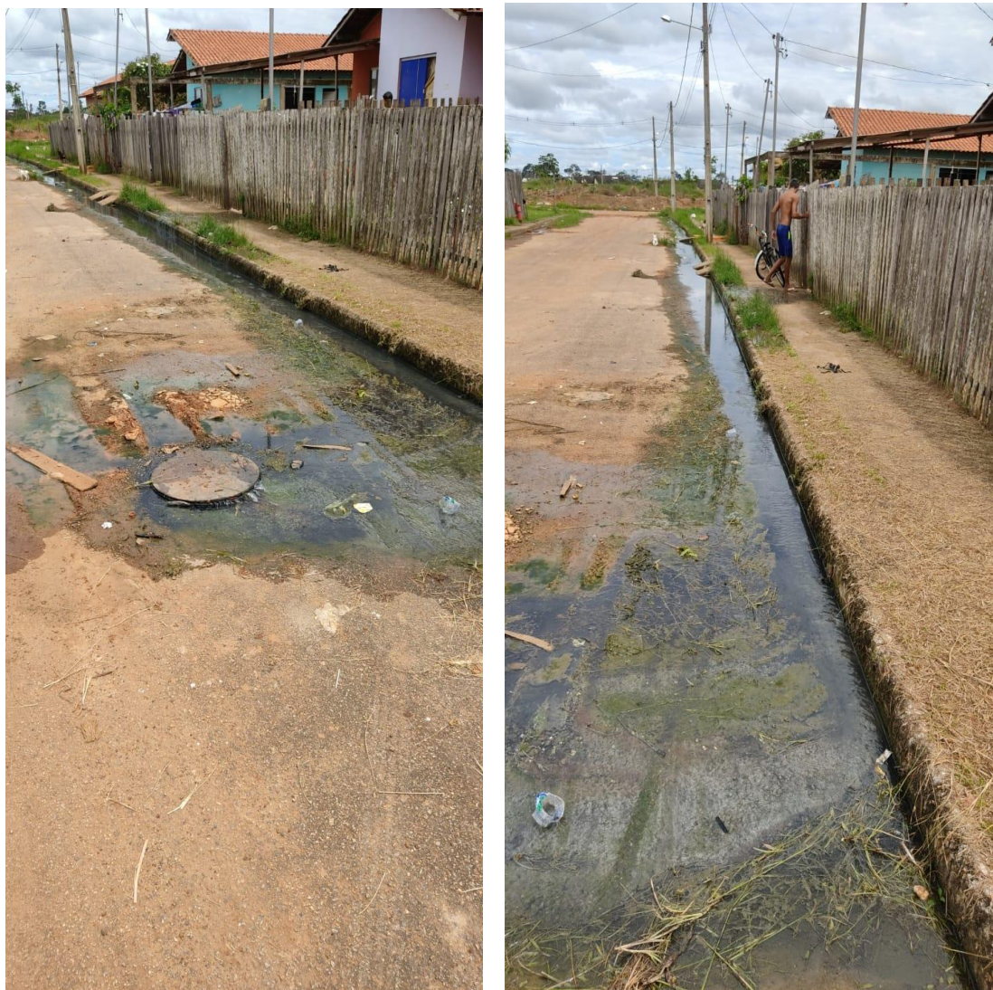
Figura 1 – Esgoto transbordando e acumulado por toda a rua.
