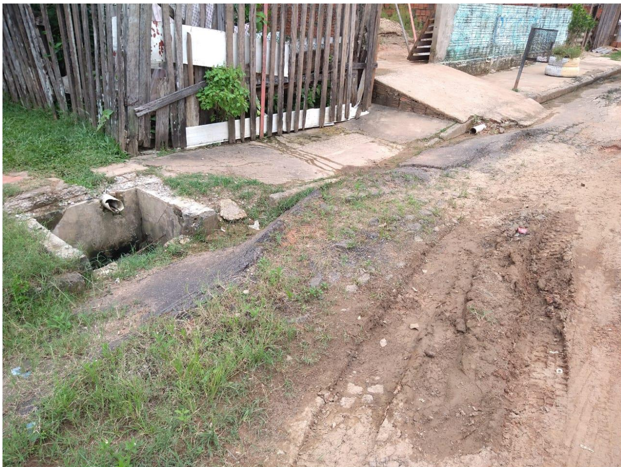
Figura 2 – Rua Arara – reparos na pavimentação e capina.
