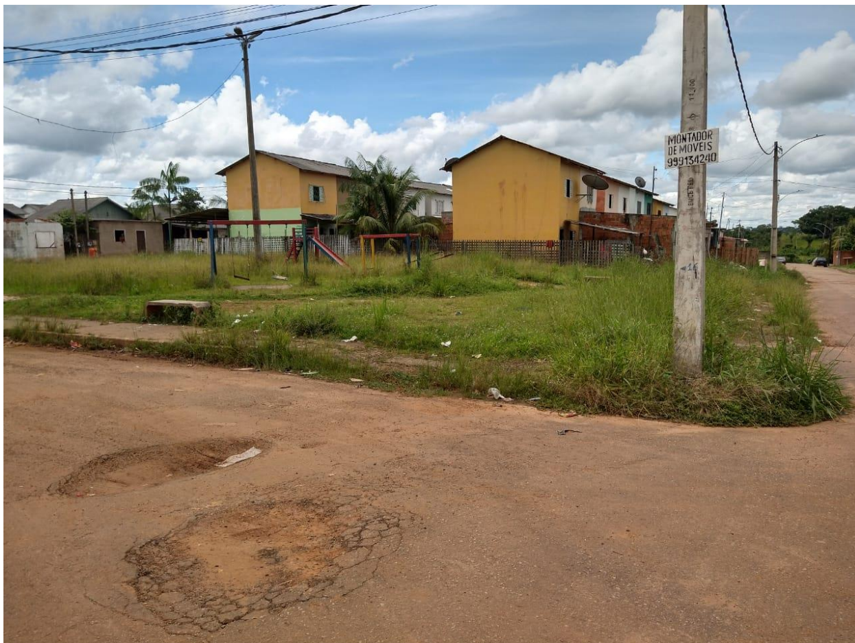
Figura 2 – Rua Aracauã – reparos na pavimentação, capina e revitalização doquinho.
