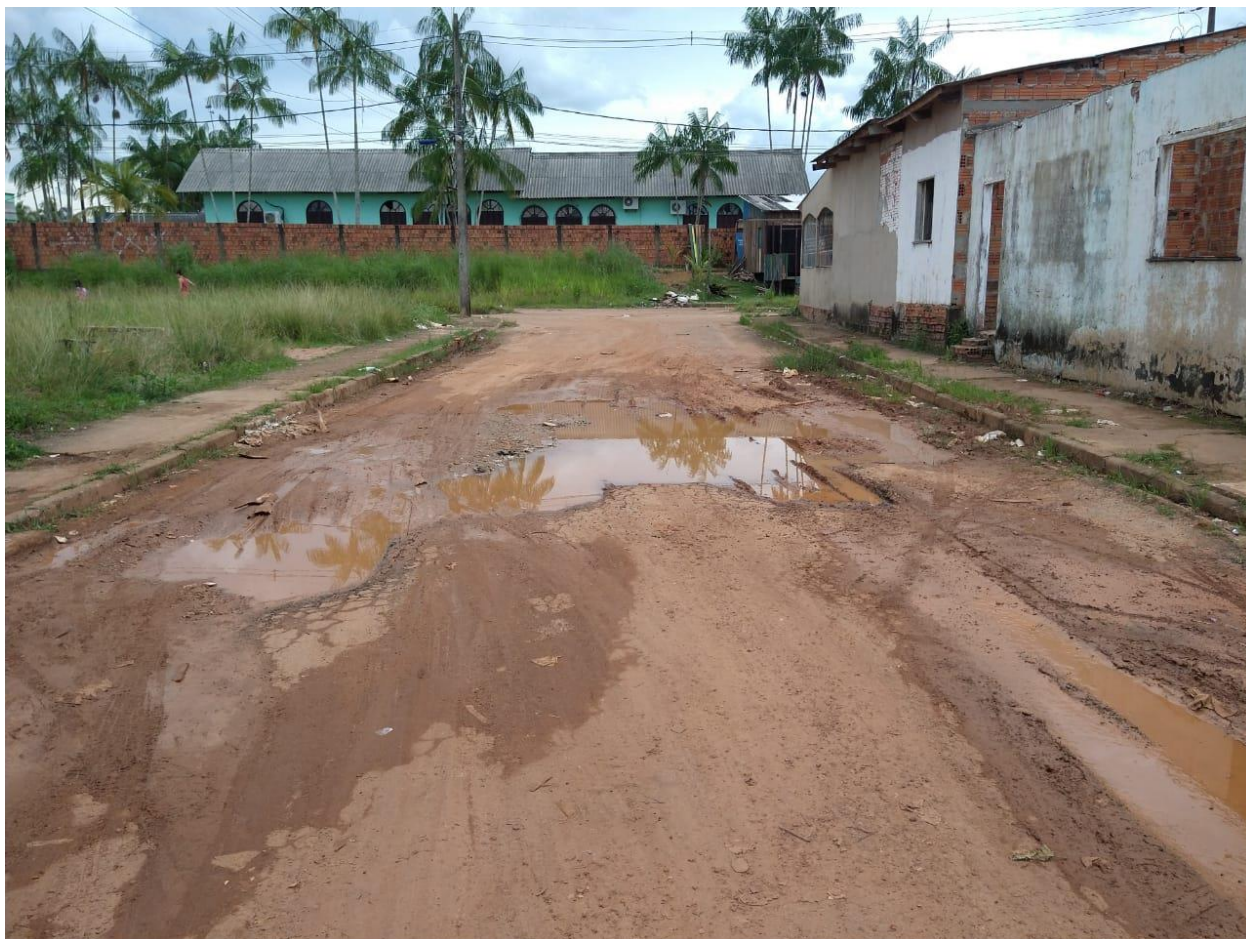
Figura 1 – Rua que necessita de reparos.
