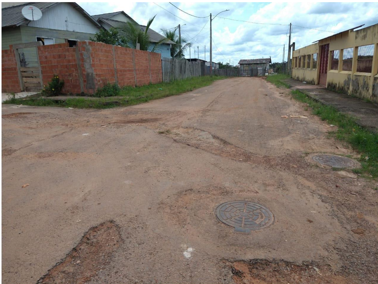
Figura 2 – Rua Arauna – reparos na pavimentação e capina.
