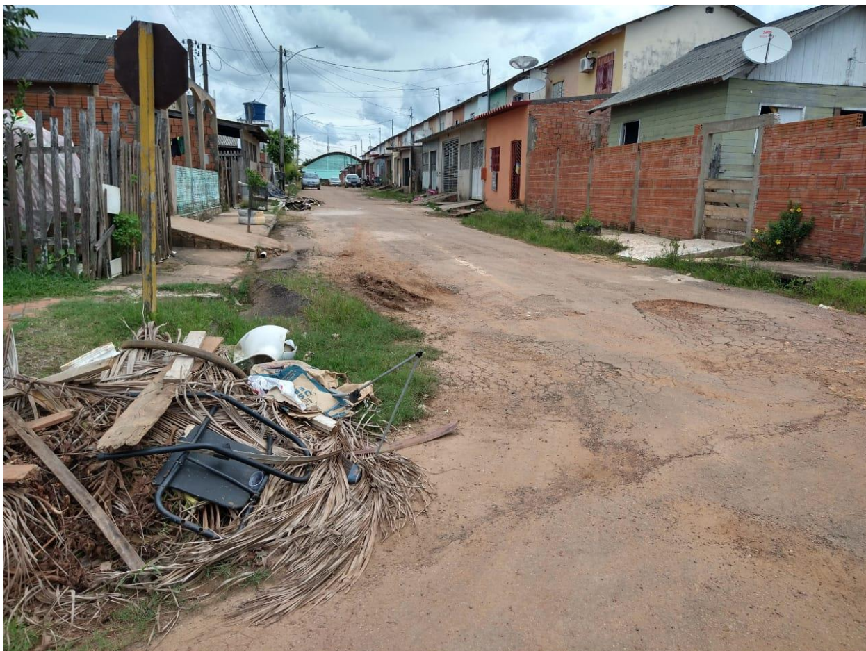
Figura 1 – Rua que necessita de reparos.
