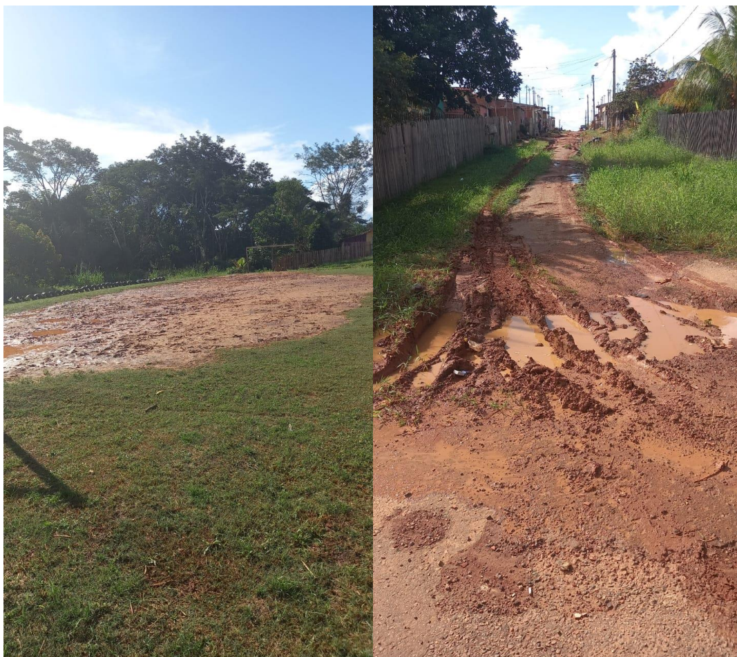
Figura 1 – Rua com bastante problema no asfalto.
