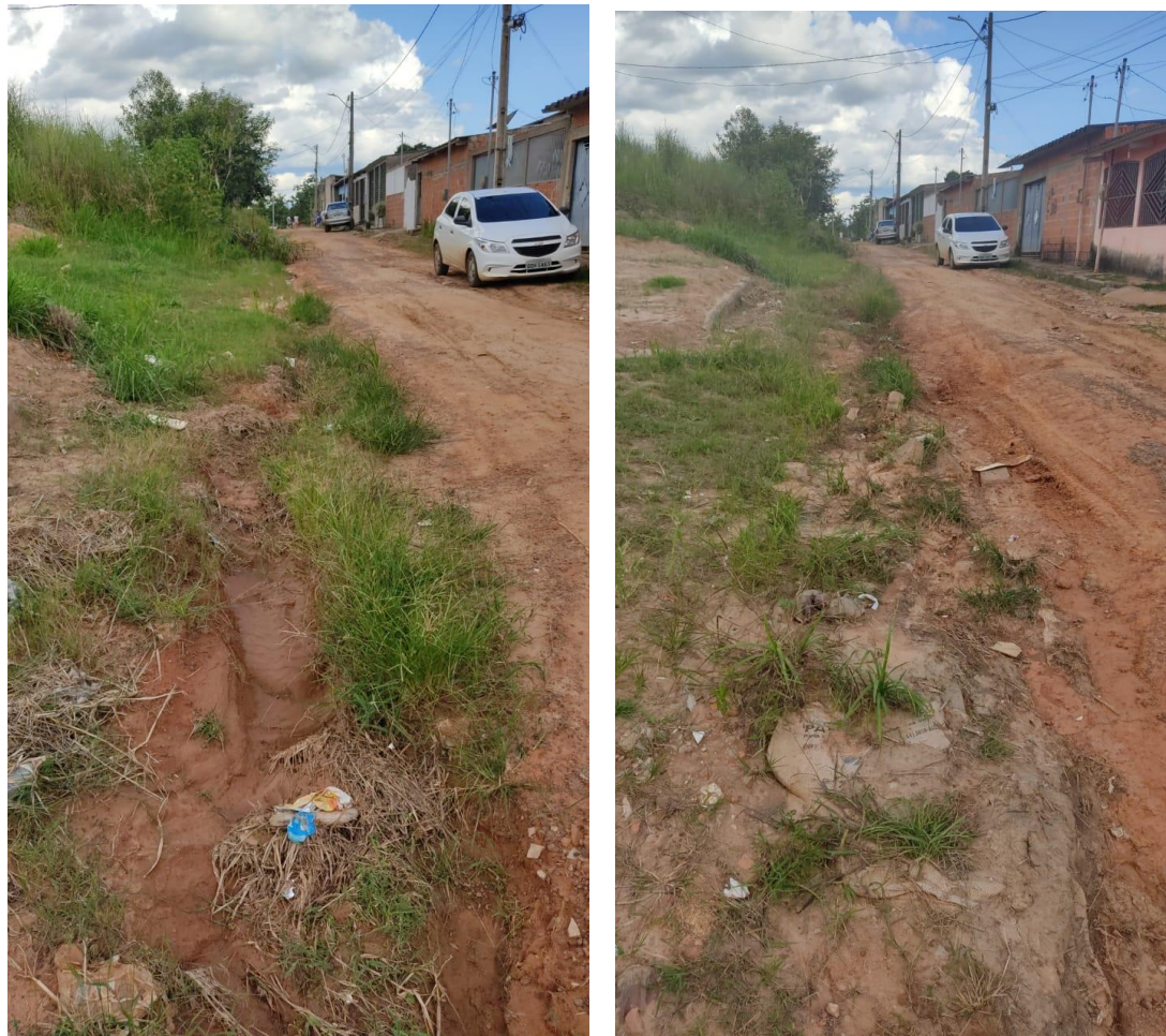
Figura 2 – Áreas precisando de roçagem e limpeza de entulhos.
