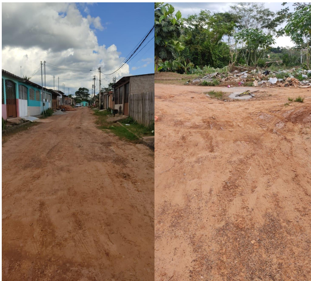
Figura 1 – Rua sem asfalto e drenagem adequada, precisando de retirada de lixo.
