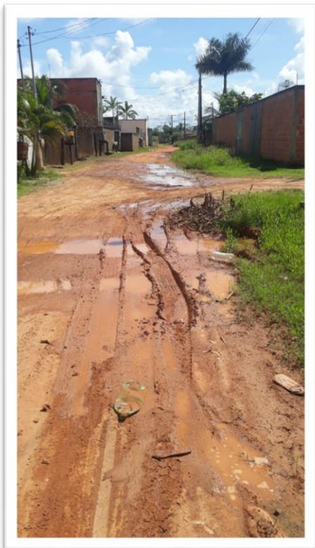
Figura 1- Pavimentação de via pública.
